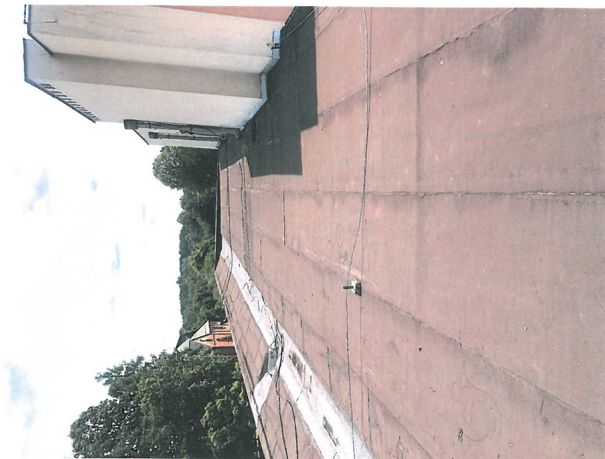
Dach nad łącznikiem (papa podkładowa)
